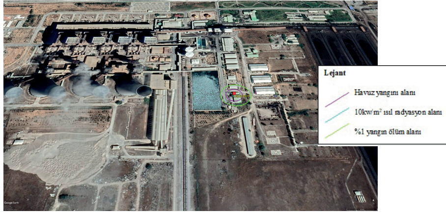
Şekil 2. 35. | Afşin Elbistan B Termik Santrali İşletme Müdürlüğü'ne Ait Tehlike Analizi
